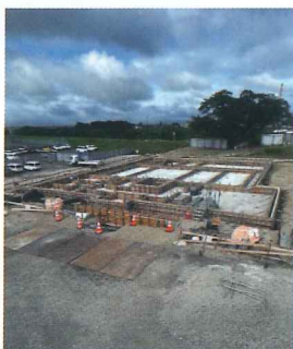
▲7月現在の工事状況
