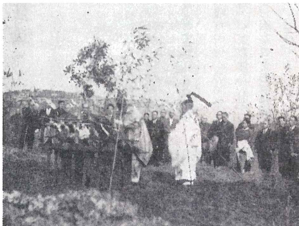
庁舎地鎮祭(昭和39年11月25日)。工事費は3,481万円。同じ年、伊達中学校の体育館も建設着工。
